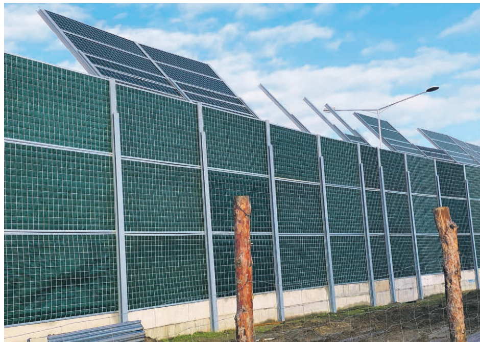
Stan zaawansowania prac na 14 stycznia 2023.
